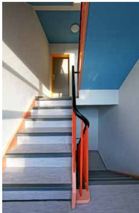
Die sanierten Treppenhäuser sind teils mit kräftigen Farben, wie hier die Decken in einem leuchtenden Blau, gestaltet.
